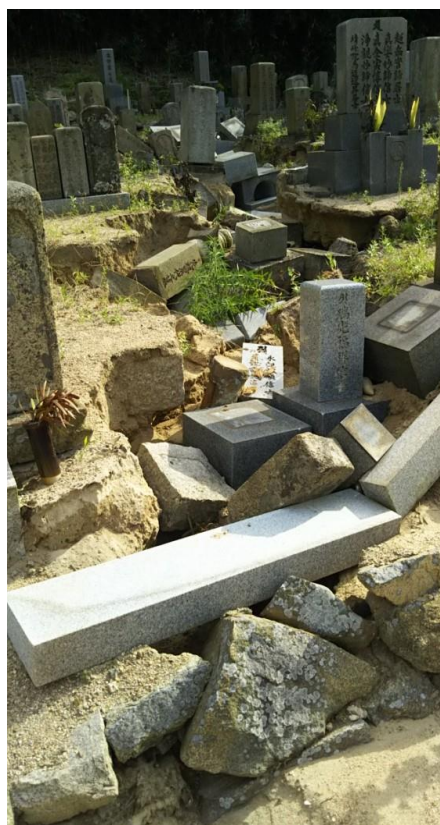
台風で倒れた墓の修復
